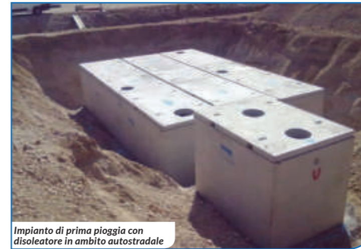
Impianto di prima pioggia in costruzione
