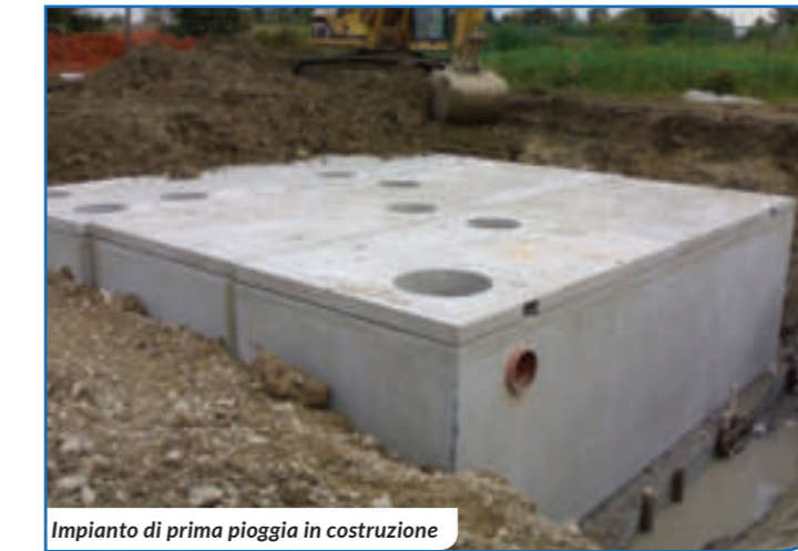
Impianto di prima pioggia in costruzione
